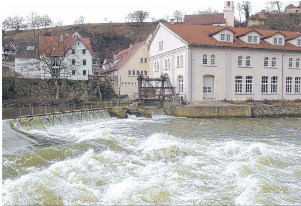
Die Wehranlage beim Wasserkraftwerk in Rechtenstein soll erneuert werden.
